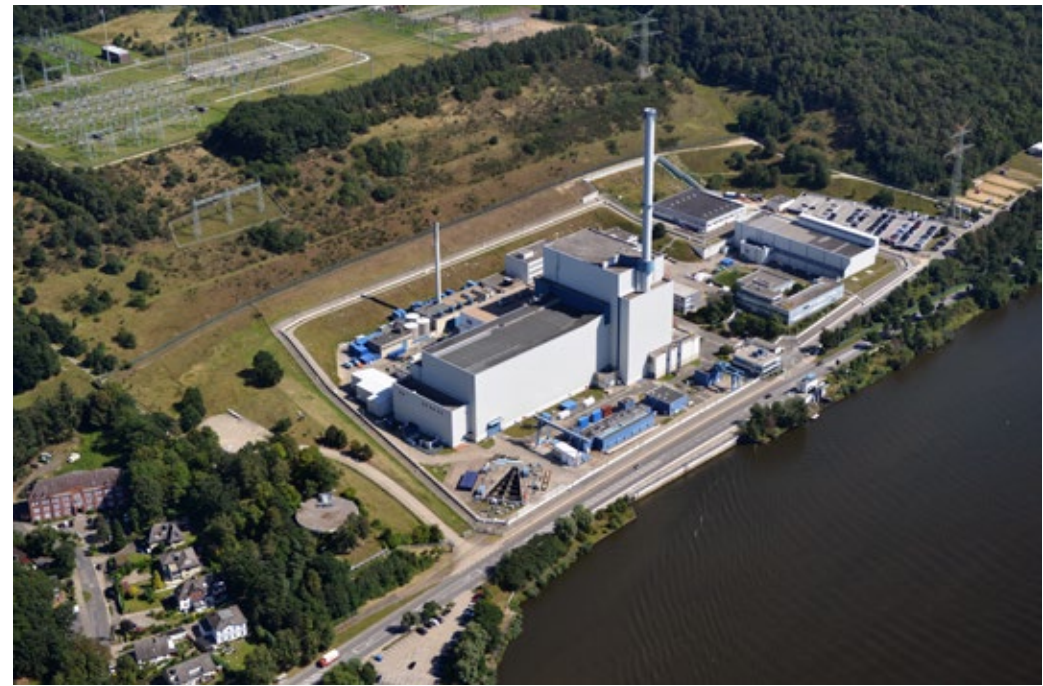
Kernkraftwerk Krümmel in Geesthacht an der Elbe.
