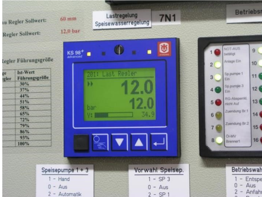
Lastregelung Hilfskessel
