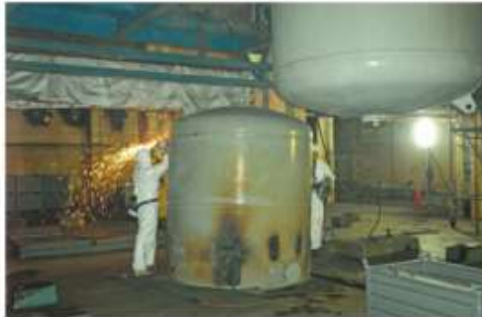
Abbau und Zerlegung von Behältern (EWN, Kernkraftwerk Greiswald)
